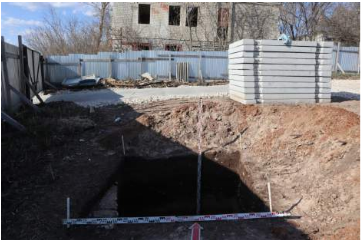
Рис. 86. Обеспечение сохранности ОКН федерального значения «Культурный слой г. Арзамаса». Нижегородская область. 2026 г. Шурф 3. Общий вид после окончания работ.
