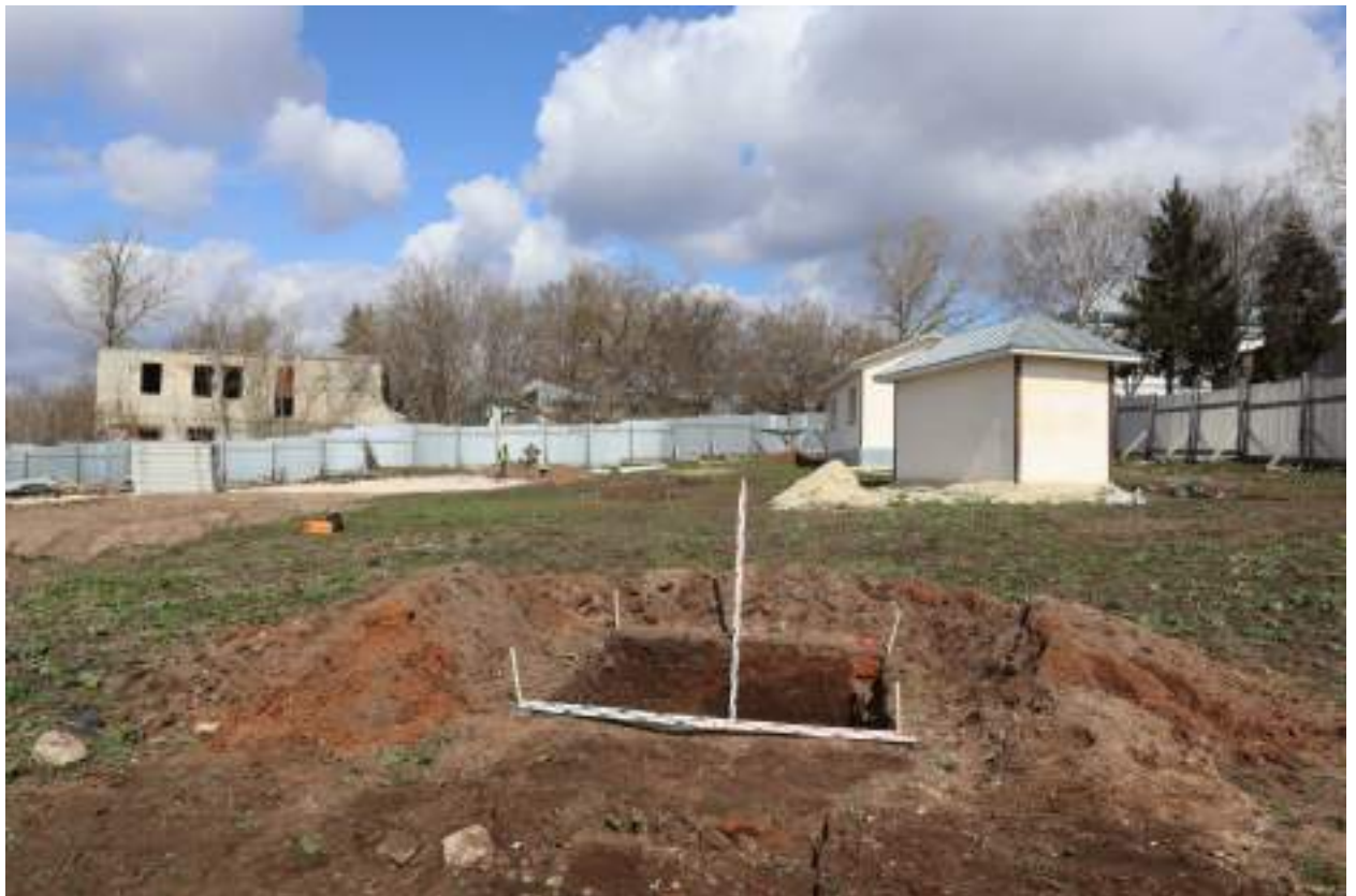
Рис. 139. Обеспечение сохранности ОКН федерального значения «Культурный слой г. Арзамаса». Нижегородская область. 2026 г. Шурф 6. Общий вид после окончания работ.
