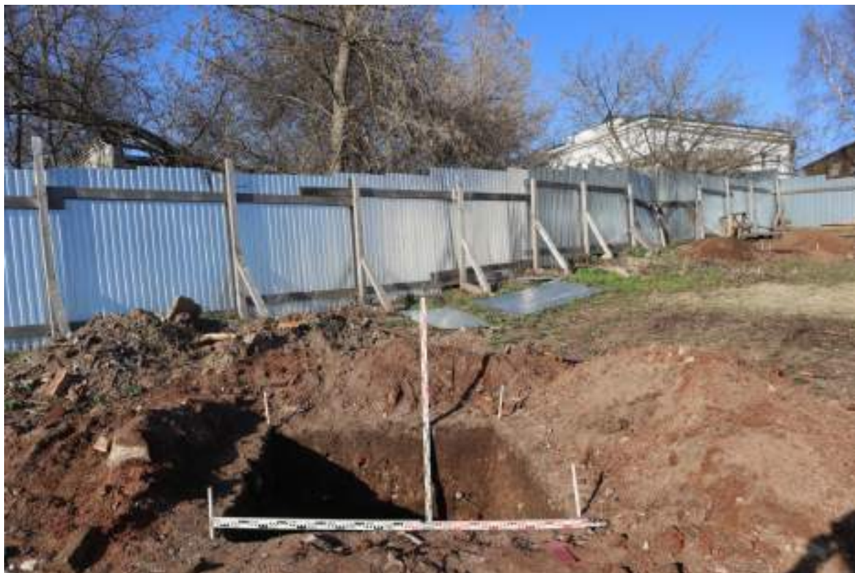
Рис. 45. Обеспечение сохранности ОКН федерального значения «Культурный слой г. Арзамаса». Нижегородская область. 2026 г. Шурф 1. Общий вид с Ю после окончания работ.
